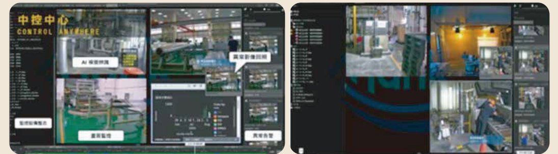
CCTV+AI熱媒油偵煙系統
